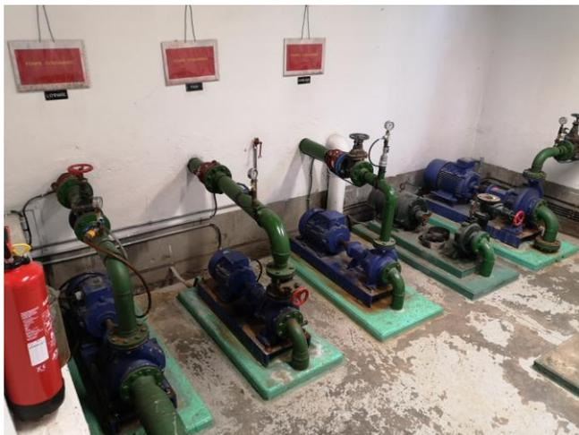
Pompes pour compléter ou alimenter les canaux de l'ASA (Usine électrique EDSB)
